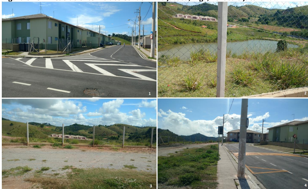
Figura 6.13 – Visão do entorno dos Condomínio Jatobá, Ingá, Peroba e Jacarandá
